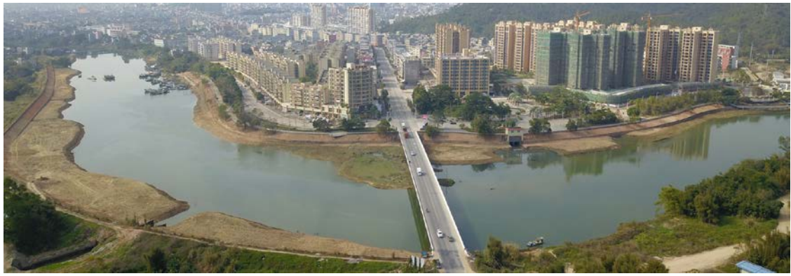
图 6.3-2 丹江干流城区段堤防建设现状图
