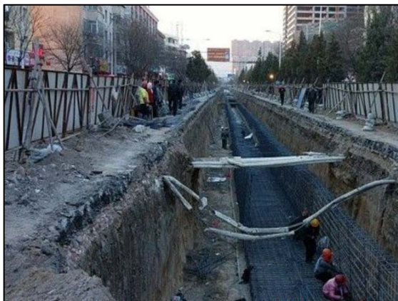
a. 老城区截污及排水管网改造工程
